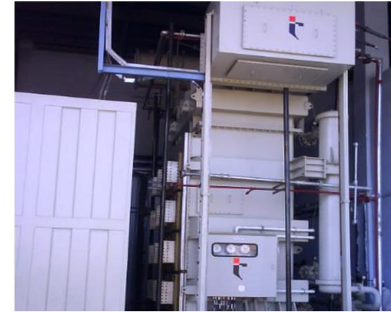
Rectifier Transformer
